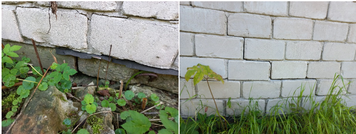
Fotod 6, 7. Vundamendis ja välisseinas olevad praod
